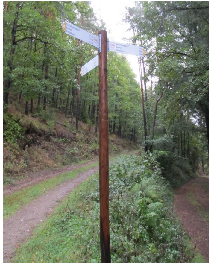
Rechts: Wegweiser mit Wurzelpfahl und Pfosten
