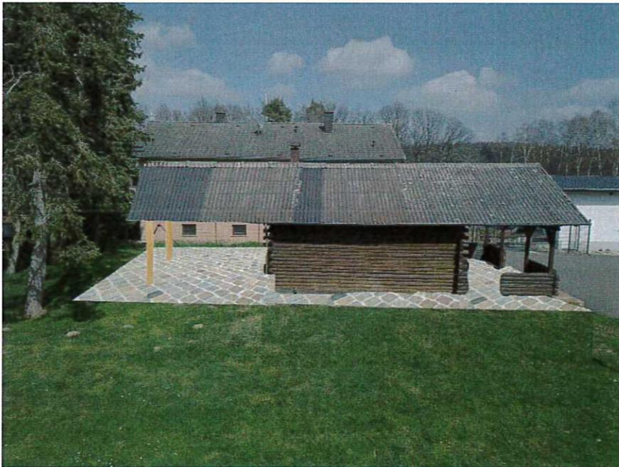
Grillhütte mit verlängerter Überdachung im linken Bereich, Befestigung der Bodenfläche durch Pflaster und Durchbruch am Außengeländer zur barrierefreien Erschließung.
