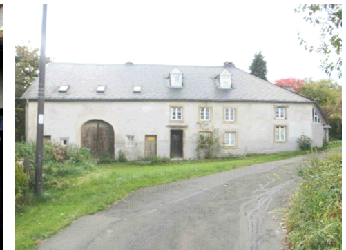
Abb. 7b: Bereits gefördertes Denkmal, für das die Ortskernsanierung eine förderliche Milieustärkung bewirken kann.
