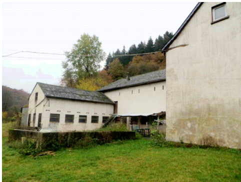
Abb. 4.4.2a: Betriebsgebäude, zusammen mit historischem Wohnhaus leerstehend
