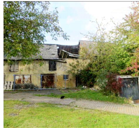
Abb. 4.4.1a: Betriebsgebäude, das hohen Sanierungsbedarf bzw. Abbruchreife hat.
