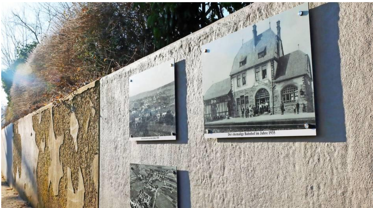
Die historische Bildergalerie in Thalfang wird ergänzt, sobald die Mauer gegenüber dem Haus der Begegnung fertiggestellt ist. Foto: Herbert Thormeyer
