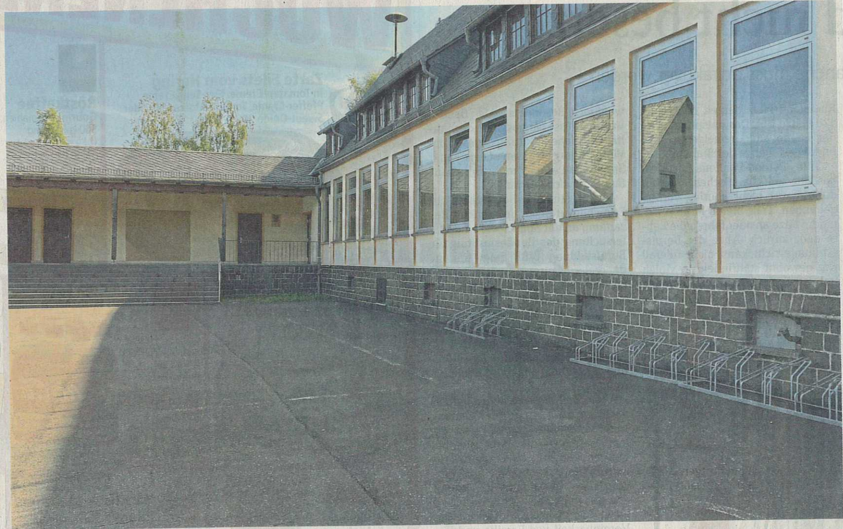
Die ehemalige Grundschule in Ruschberg wird zum Gesundheitspunkt umgebaut, der nicht nur älteren Menschen Möglichkeiten bietet, sich fit zu halten. Der Gemeinderat hat nun erste Planungsleistungen vergeben. Foto: Peter Bleyer (Archiv)
