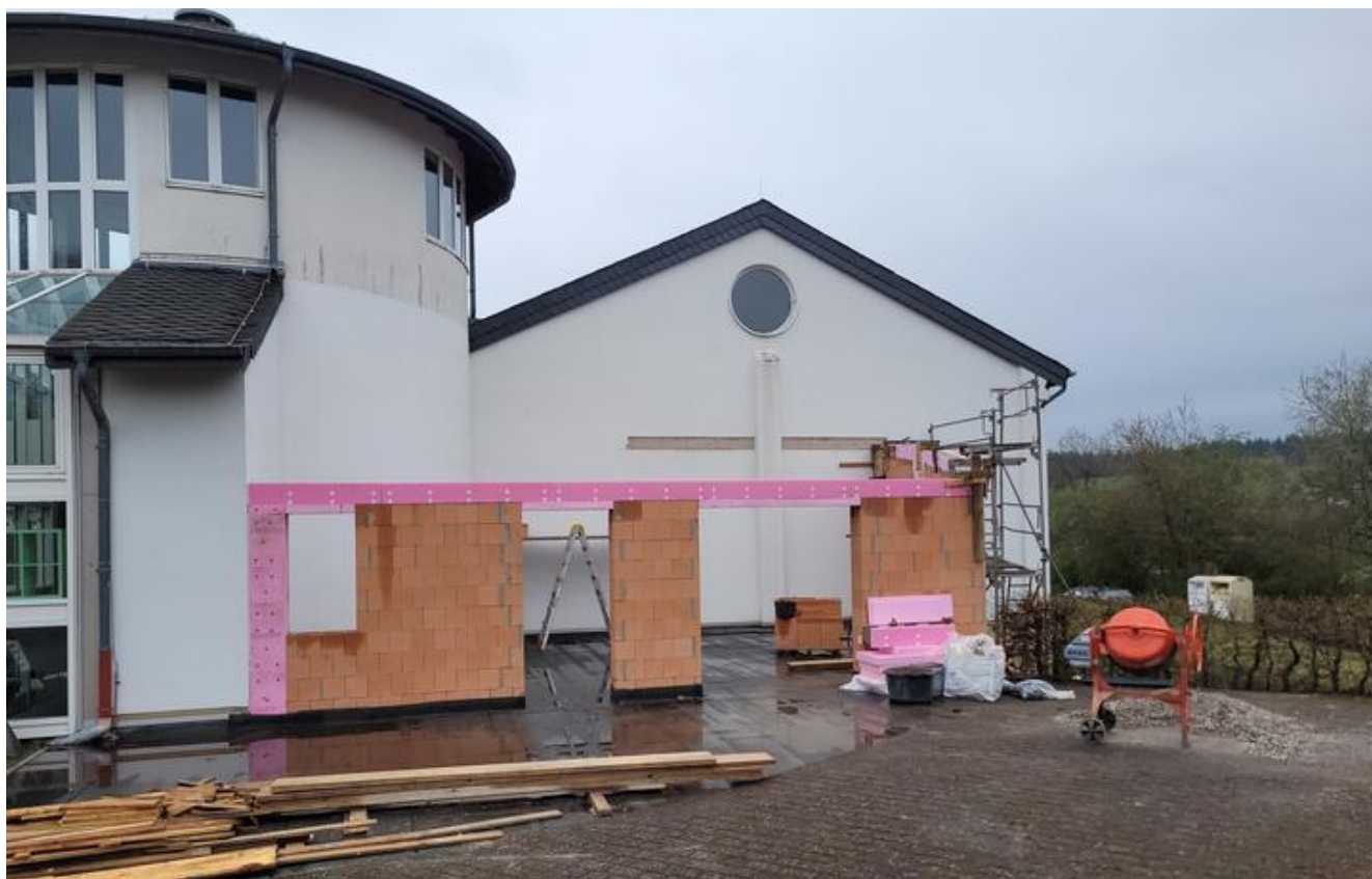
Der Bau des Jugendraums am Bürgerhaus in Hettenrodt hat begonnen. Foto: Ortsgemeinde Hettenrodt
