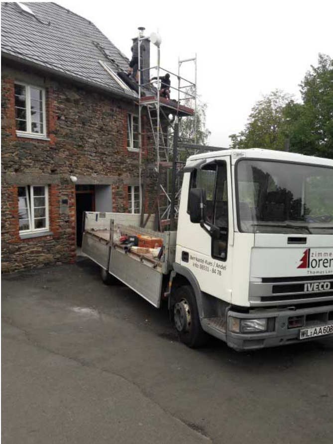
Bilder Handwerkerleistungen Der Dachdecker
